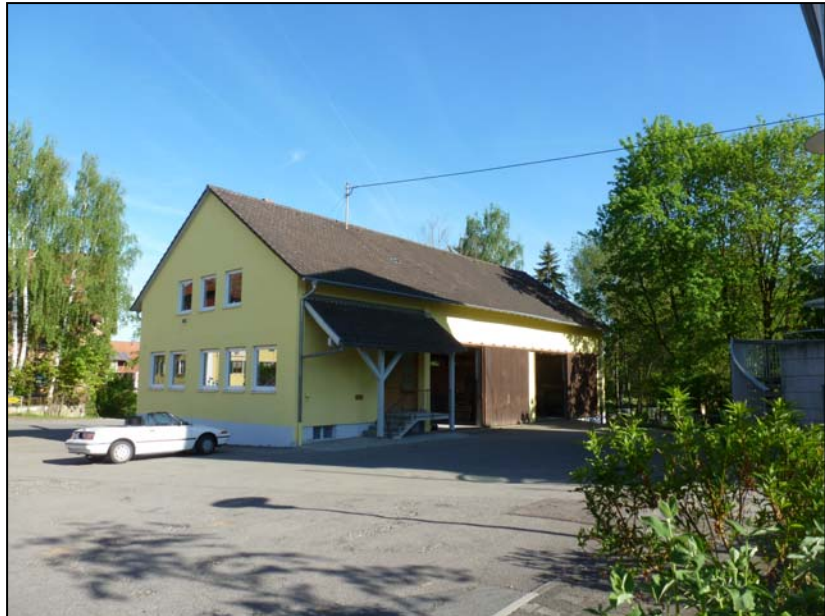
Ehemaliges Raiffeisen- Lager nach Umbau
